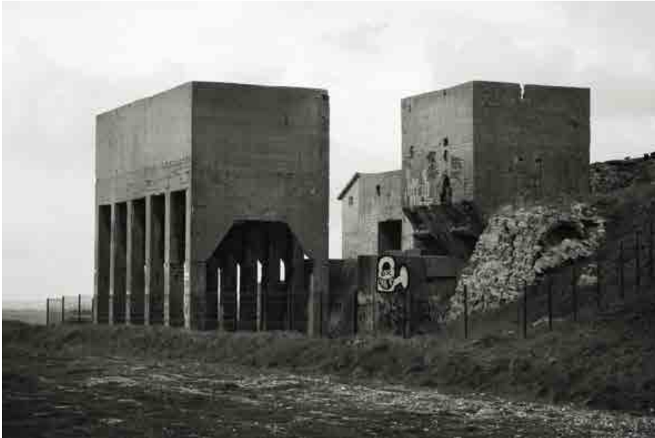
> Silos, usine de concassage de galets, Prat ar Hastel, Tréguennec
