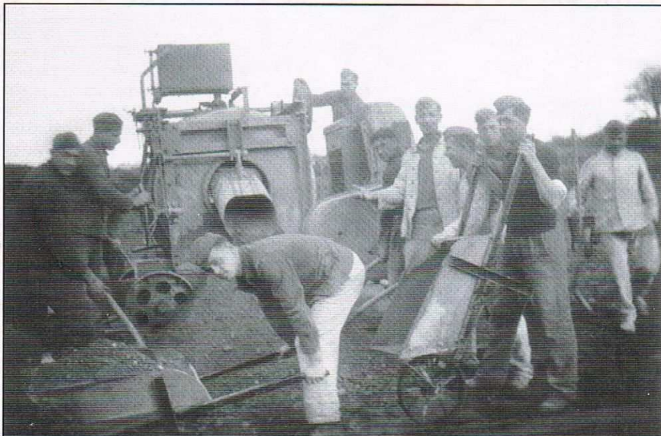
Ci-contre : quelque part en Cornouaille. Construction de défenses de campagne bétonnées par les Pionnere .
