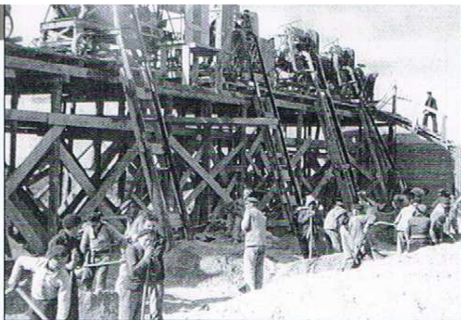
Ci-dessus : les requis de l'Organisation Todt en plein travail de bétonnage dans le secteur de Kermabec-plage. (Coll. E. Rouillé.)
